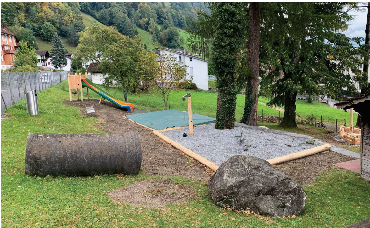
Sanierung Spielplatz Rosstal
